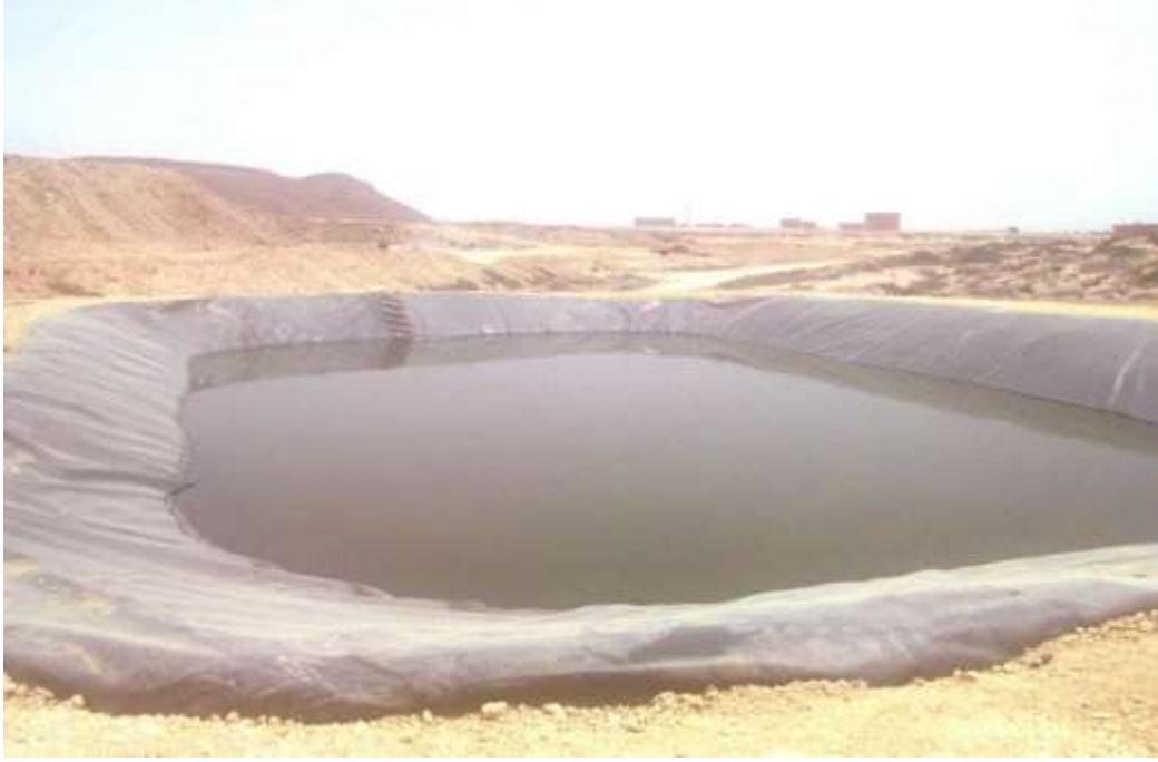
شكل (20). خزان لحفظ المياه - شركة نيكسن - قطاع 14
