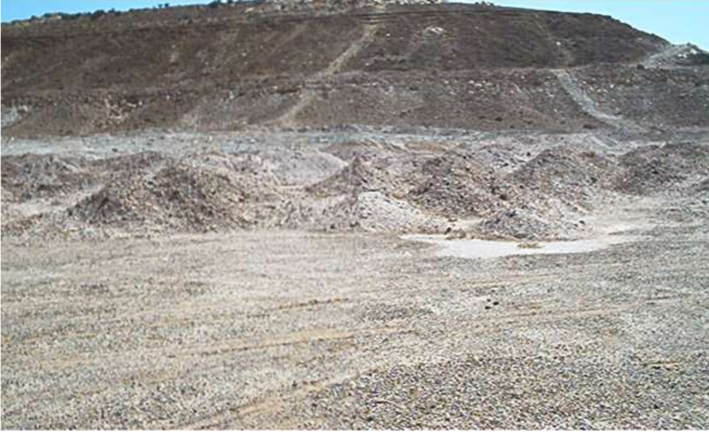
شكل ( 15 ). الموقع الذي تم نقل النفايات اليه، ويتضح عدم وضع عازل لمنع تسرب التلوث الى طبقات الارض ومن ثم الى المياه الجوفية، والموقع غير مرخص للتخلص من النفايات.
