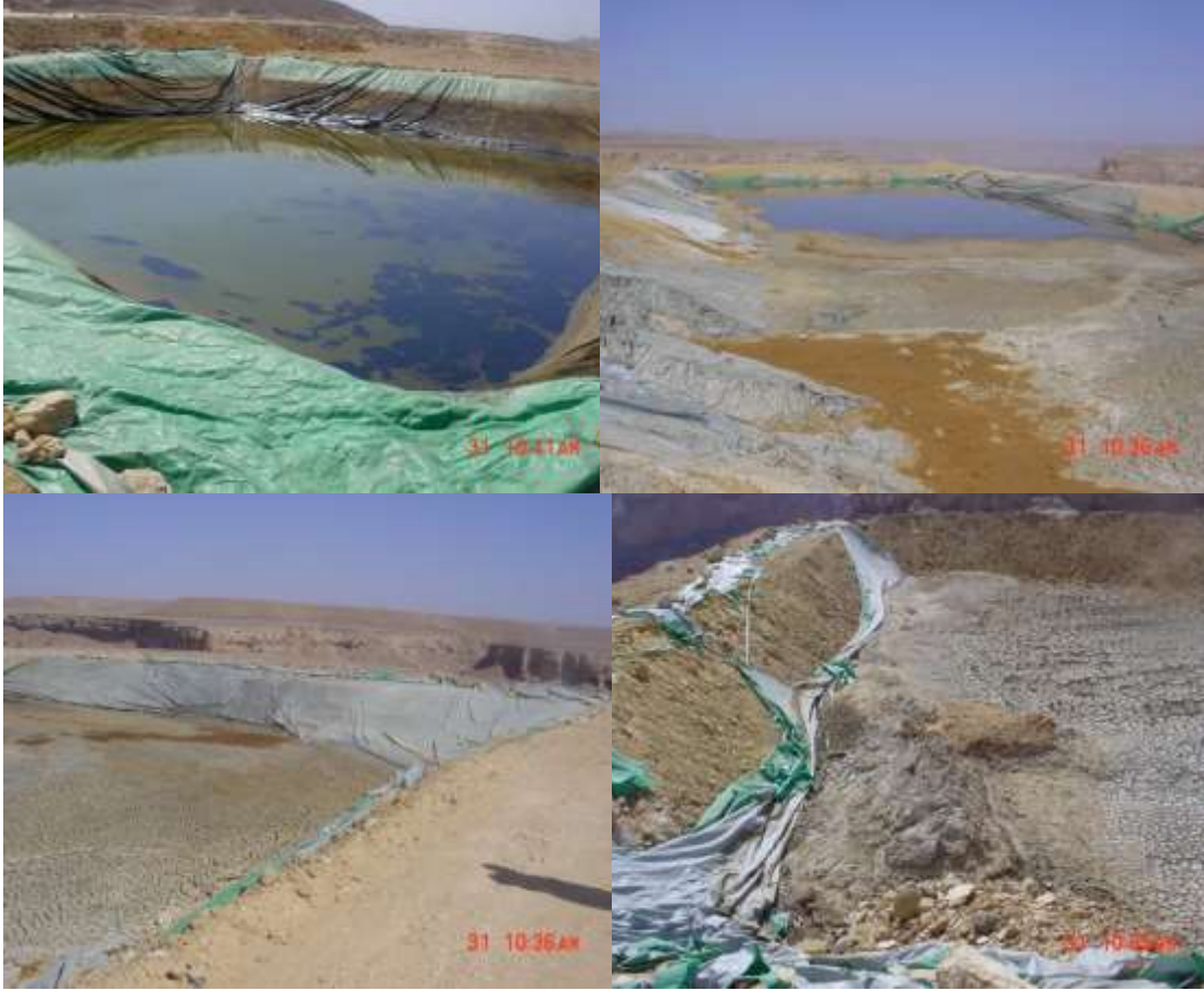
شكل (19). يوضح فشل بطانة الخزان لعدم مطابقتها للمواصفات البيئية المطلوبة للمنطقة - شركة Dove .
