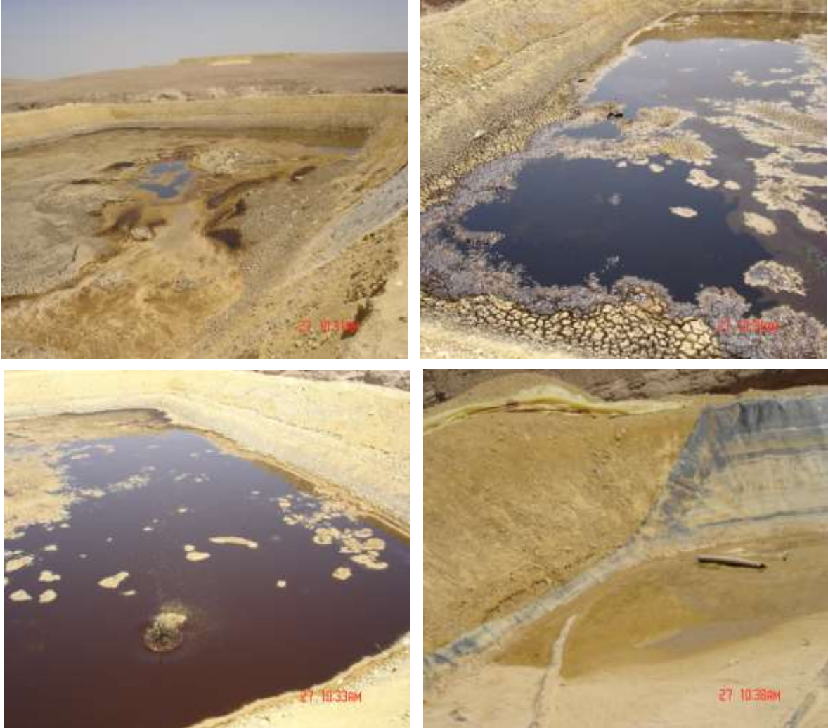
شكل (22). حفر تخزين مياه وسوائل الحفر - شركة توتال - قطاع 10. يلاحظ الاحتمالية العالية لتسربها عبر الطبقات لتسبب تلوث المياه الجوفية.
