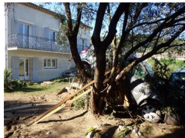
Biot (06), France, après inondations en octobre 2015
